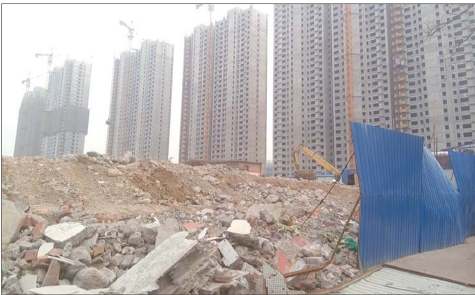
隆悦花园回迁小区在建楼盘。
