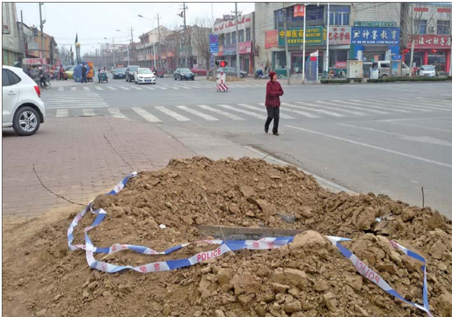
路口的交通信号灯基础坑。 本报记者 张健 摄
