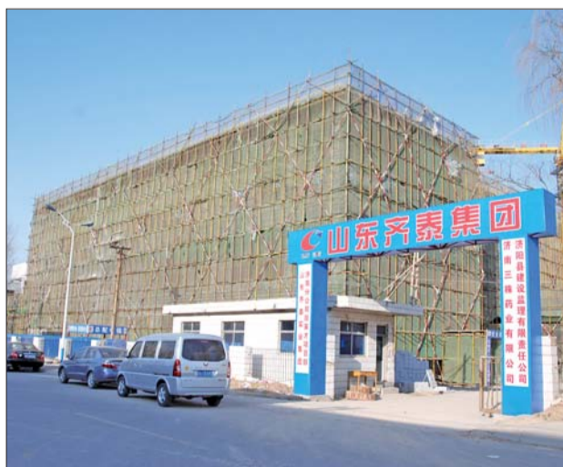
三株商学院施工现场。 本报通讯员 吴莎莎 摄
