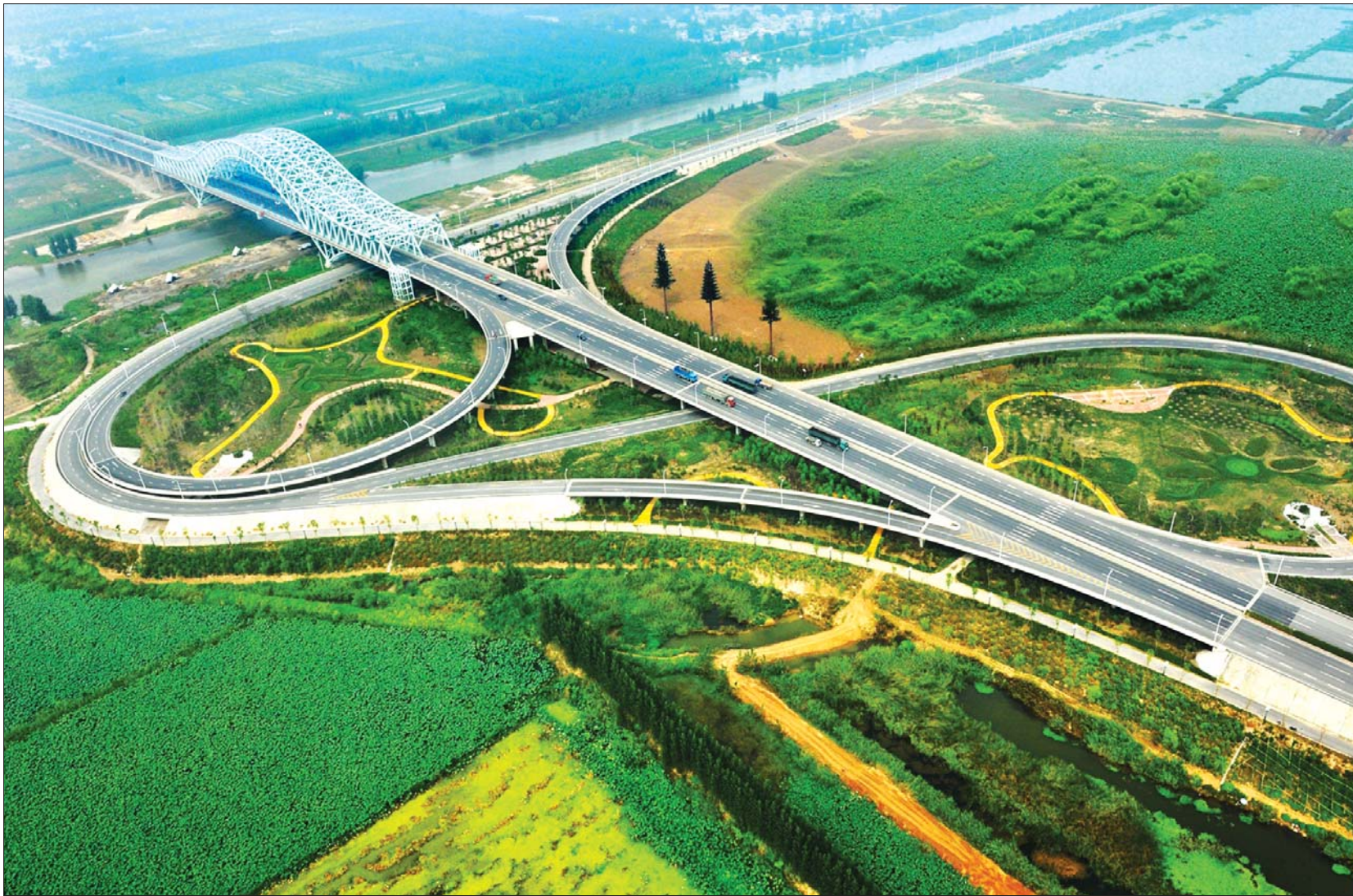
南二环运河特大桥。
