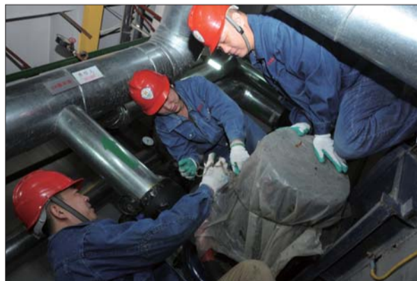
工作人员包装换热站重要设备防潮防尘。 本报记者 王鸿哲 摄
