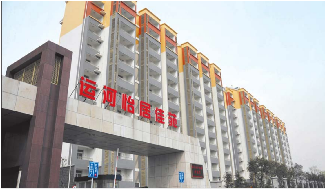
运河怡居住苑一期工程已全部建成。本报记者 康宇 摄
