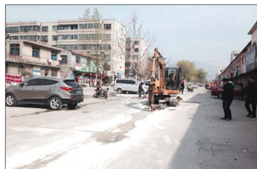
工人在施工建设社区停车场。本报记者 陈新 摄
