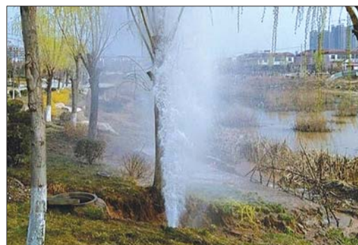
丰园小区东侧水管爆裂。市民供图
