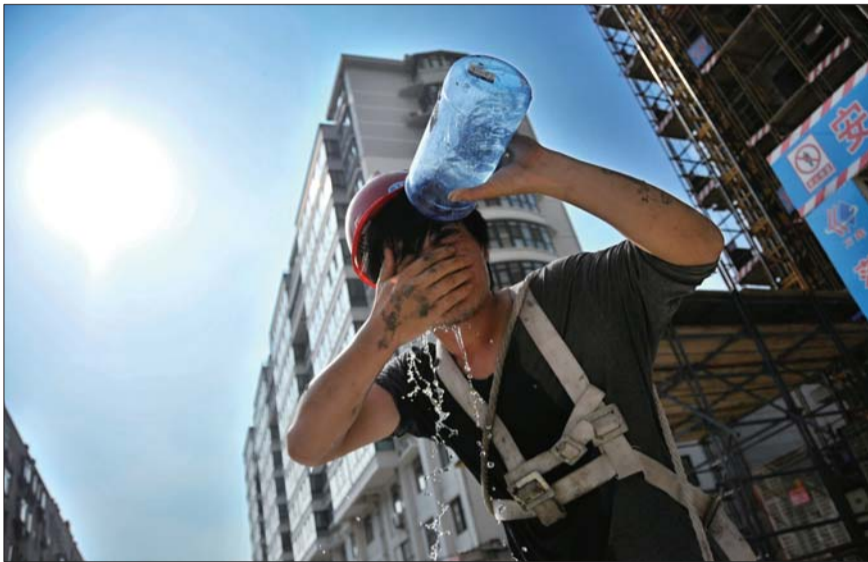
在张店柳泉路一建筑工地,工人现场工作间隙洗去脸上的汗水(资料片)。
