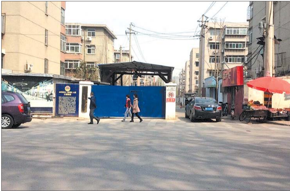
益寿路人防工程施工现场,进出小区道路被堵住一半。 本报记者 王皇 实习生 李粟 摄
