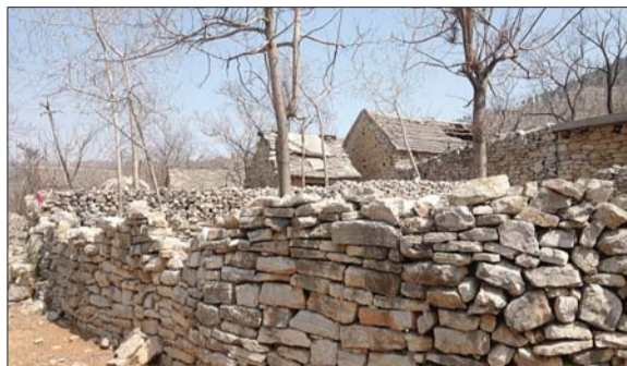
东水峪社区新居工程(改造前)
