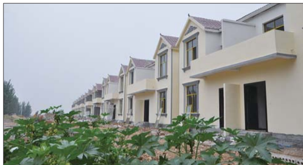
东水峪社区新居工程(竣工后)
