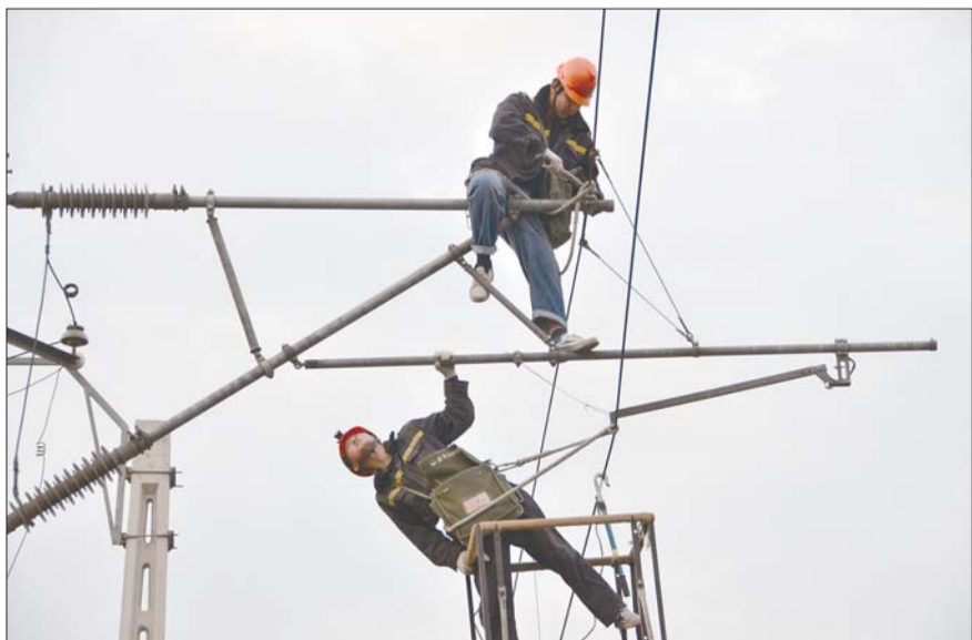
济南供电段职工在紧固接触线底座螺栓。
