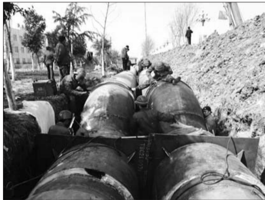
施工现场工人们正在进行管网焊接。本报记者 康宇 摄
