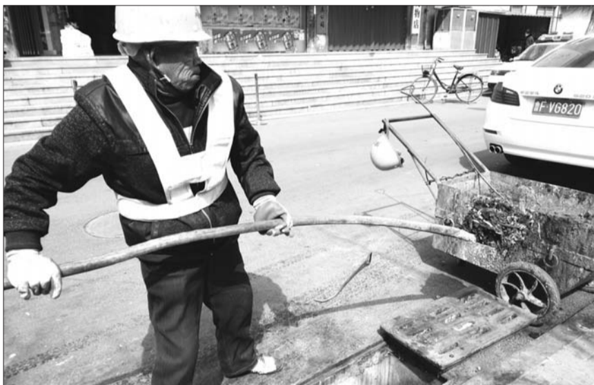
排水处工人正在清理污水管网内的淤泥和垃圾。 本报记者 张倩倩 摄
