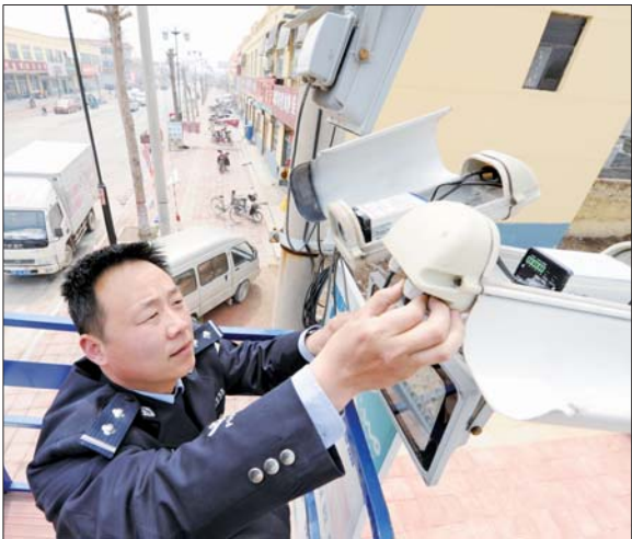
东阿县公安局大桥派出所副所长赵德迎检修监控探头。 本报记者 郭庆文 通讯员 付延涛 摄
