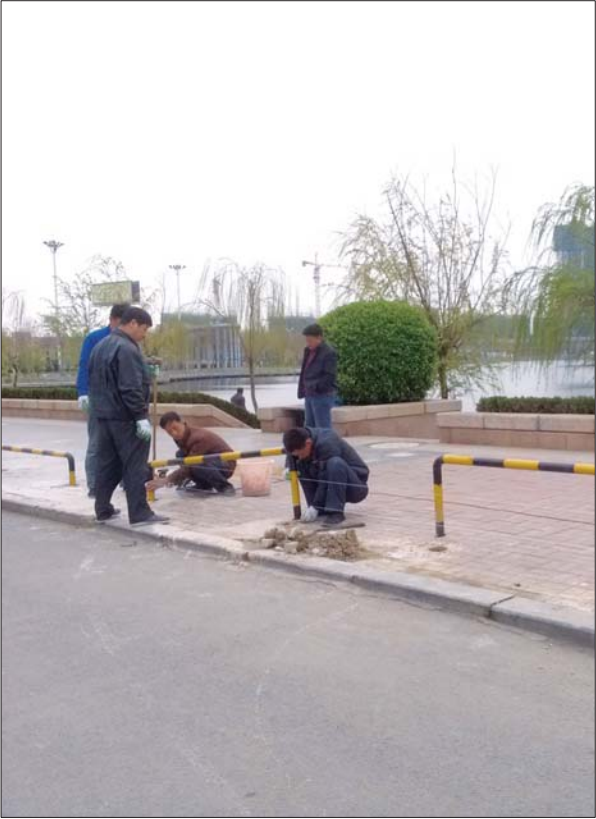
4月6日上午,工作人员正在运河公园东侧人行道安装护栏,防止车辆乱占人行道。 本报记者 徐良 摄
