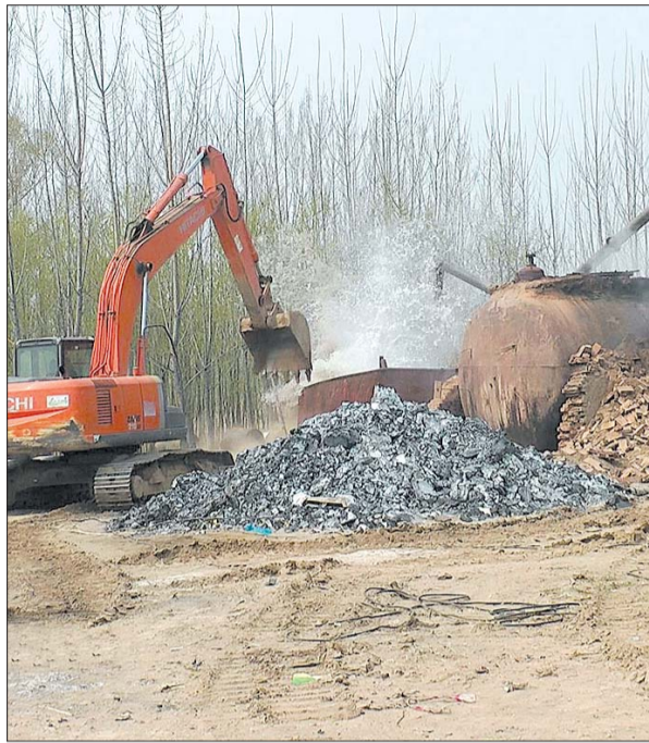
环保部门对一家土小炼油企业生产设备进行拆除。
