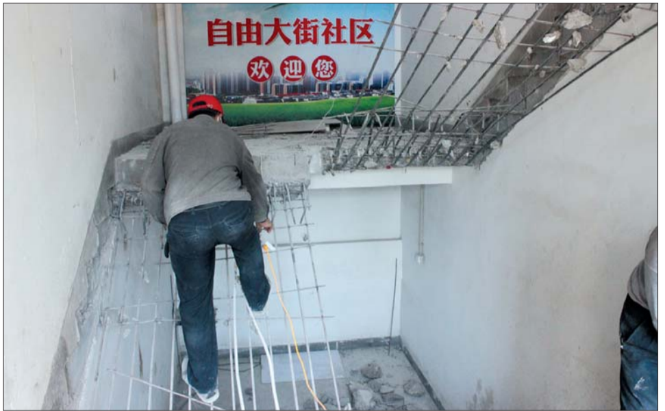
1到3层的步梯已经拆得只剩下了钢筋。 本报记者 孟燕 摄
