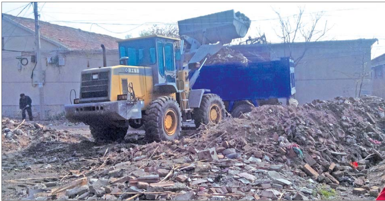
铲车正在清理家属院里的建筑垃圾。
