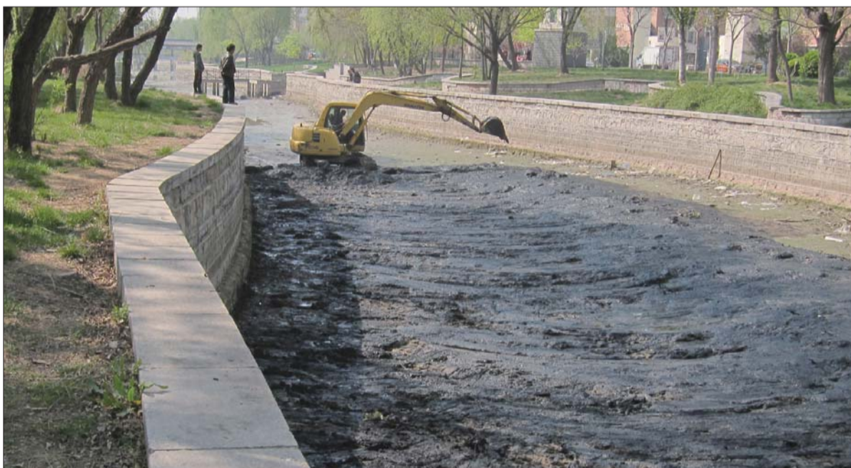
15日,在三八路至天衢路河段的沙王河内,挖掘机在清理河道附着物。 孙婷婷 摄
