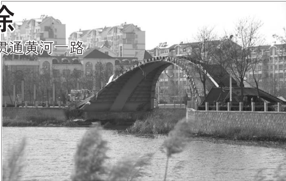
正在被拆除的彩虹湖景观桥。 本报记者 阙乐乐 摄
