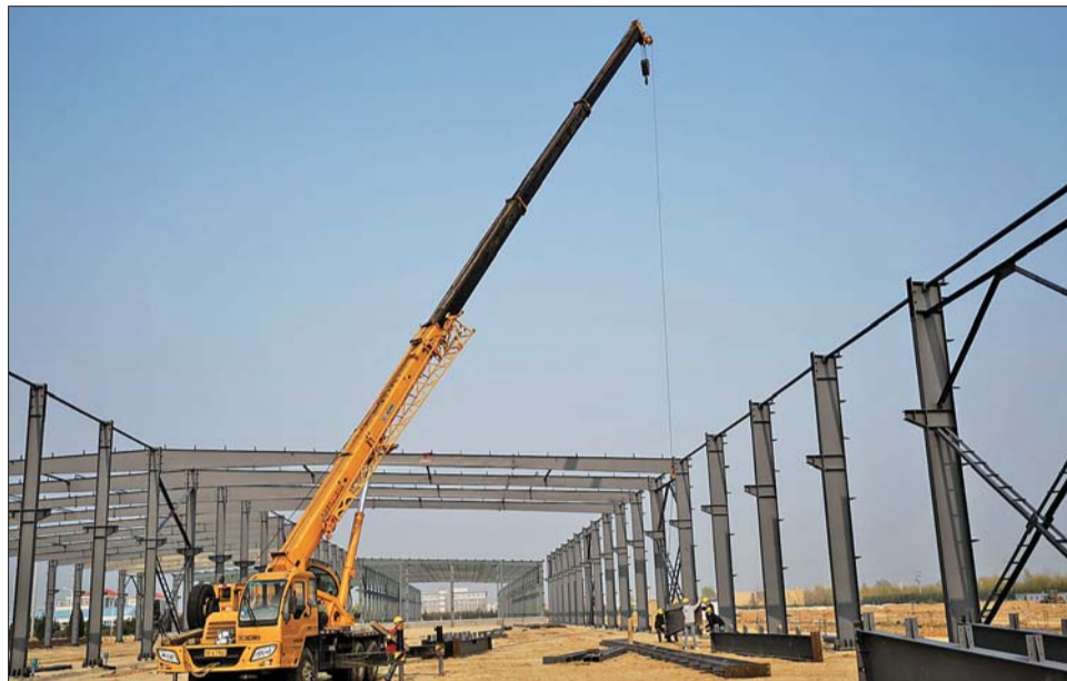
乳山滨海新区骏翔新材料项目现场,工人正在进行施工。杨大杰 摄
