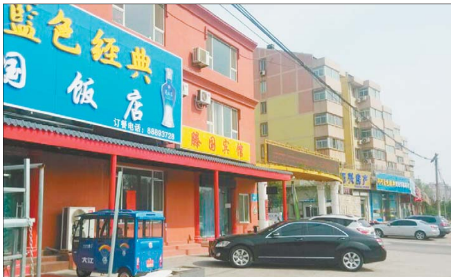
天和园小区西侧的三层楼房,其中两层已经对外出租。
