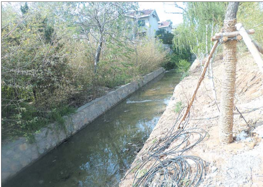
河沟距居民楼只一墙之隔,水中有很多淤泥和垃圾。
