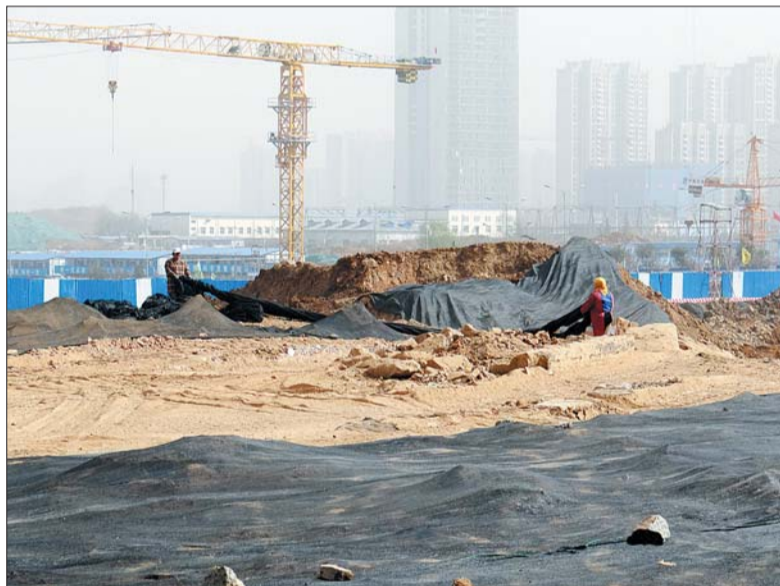
工地施工人员按照整改要求覆盖裸露渣土。
