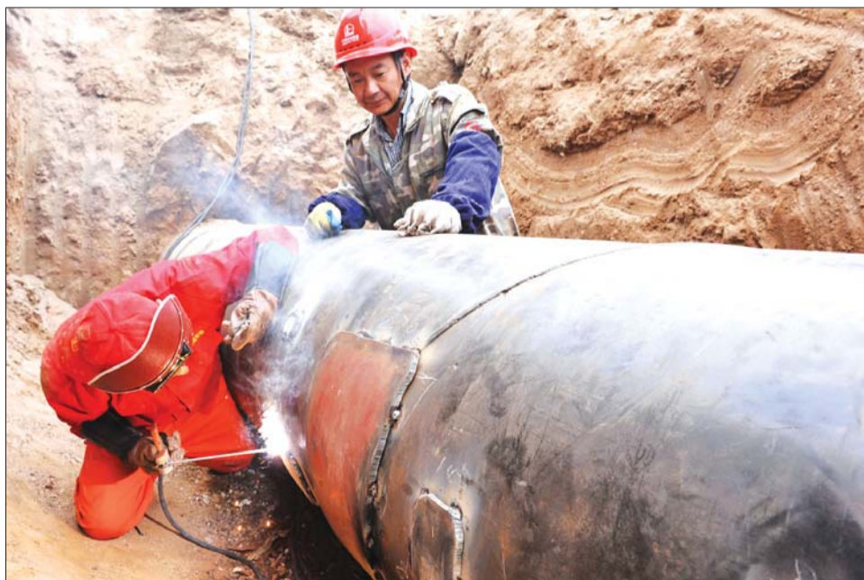
施工人员正在对管线进行维修维护。
