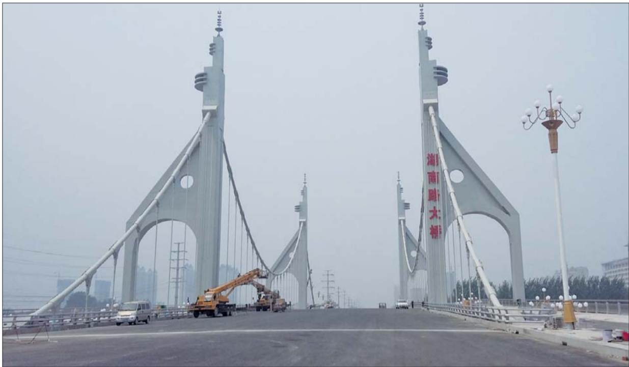
27日上午,在城区湖南路大桥,工人正在紧张进行着喷漆、贴反光带等桥梁辅助设施的施工,该桥已经全面通过桥梁荷载检测并达到通车标准,将在“五一”前确保顺利通车。据介绍,湖南路徒骇河新大桥全桥总长314米,宽度52米,最大跨度112米。机动车道为双向8车道,机动车道总宽29米,两侧人行道各宽3.5米,两侧非机动车道各宽5.5米,宽度国内同类桥梁中占第一。新桥兼顾了功能与景观,也将是徒骇河风景区乃至聊城的标志景点之一。本报记者 李怀磊 摄影报道
