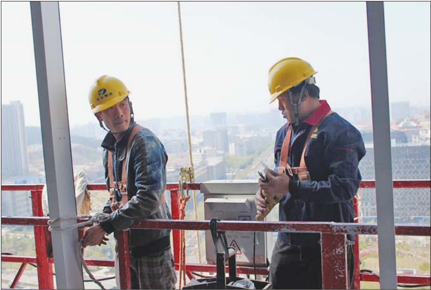
高空作业的郑富东、郑富有兄弟正在为汉峪金谷项目大楼安装幕墙龙骨。
