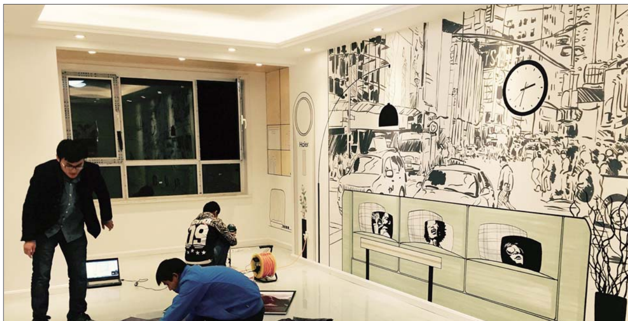
冯统的团队正在装修一个地产项目的样板间。(资料片)
