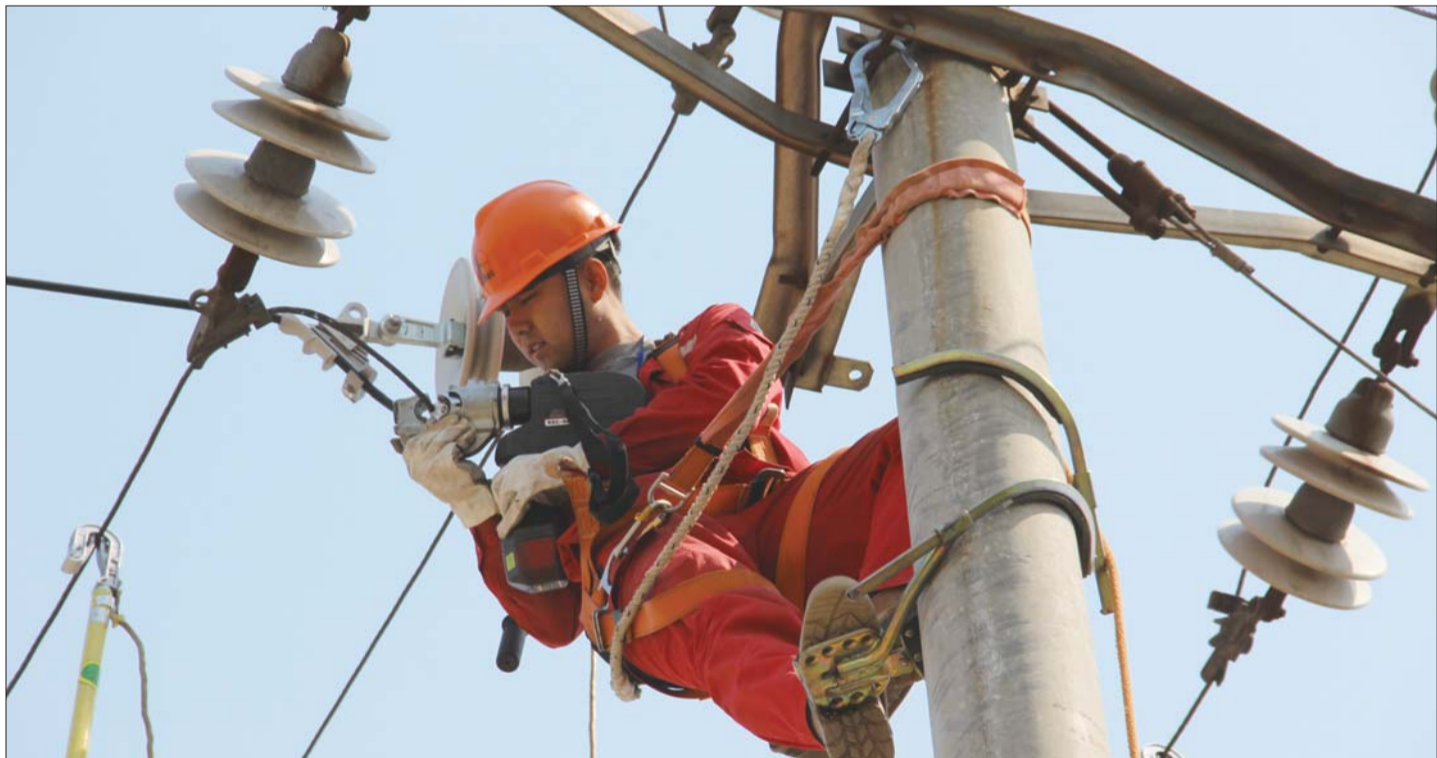
员工正在压接导线。
