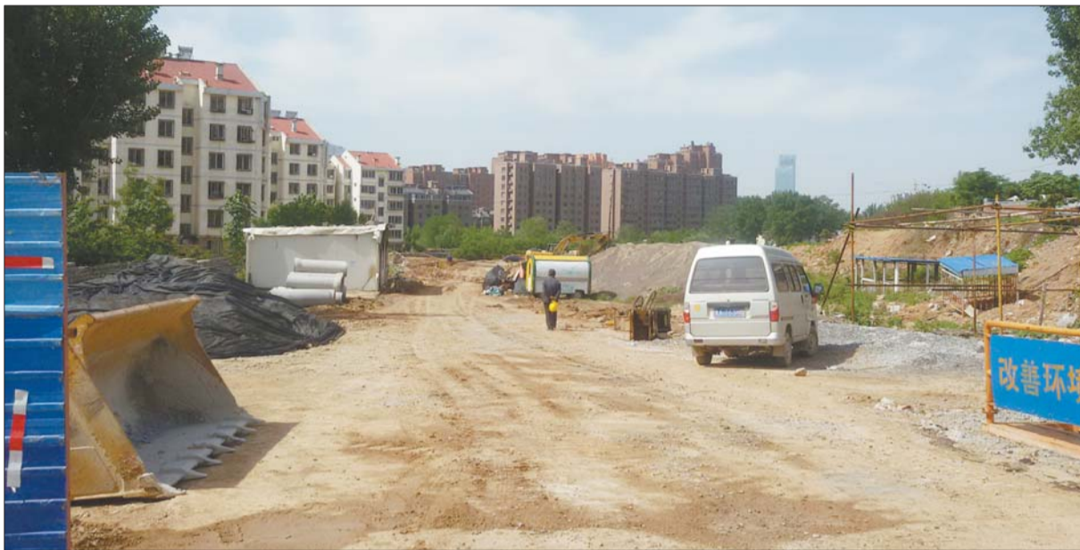
阳光舜城西侧道路二期工程拆迁难度大,进展缓慢。
