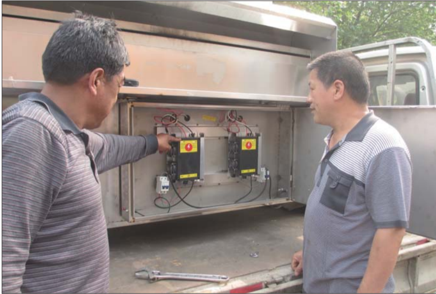
摊主正在查看无烟烧烤设备。 本报记者 刘光斌 摄
