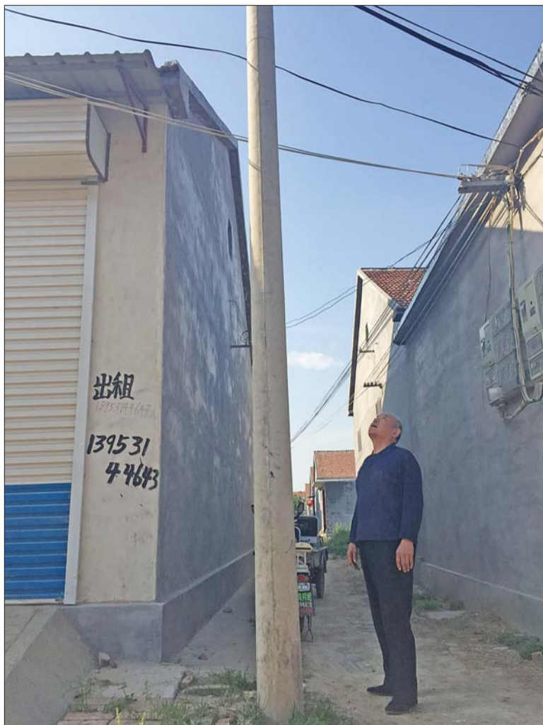
宽3米的胡同内电线杆立在中间。
