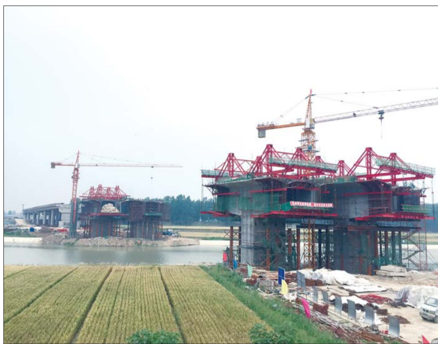
京杭运河特大桥主墩已完成,正在进行挂篮施工。本报记者 庄子帆 摄
