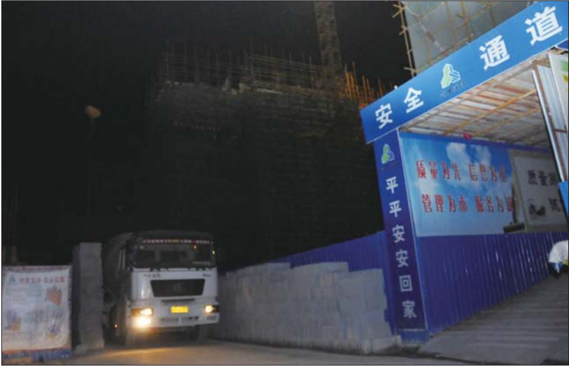
◀—建筑工地夜晚正在施工。(资料片)
