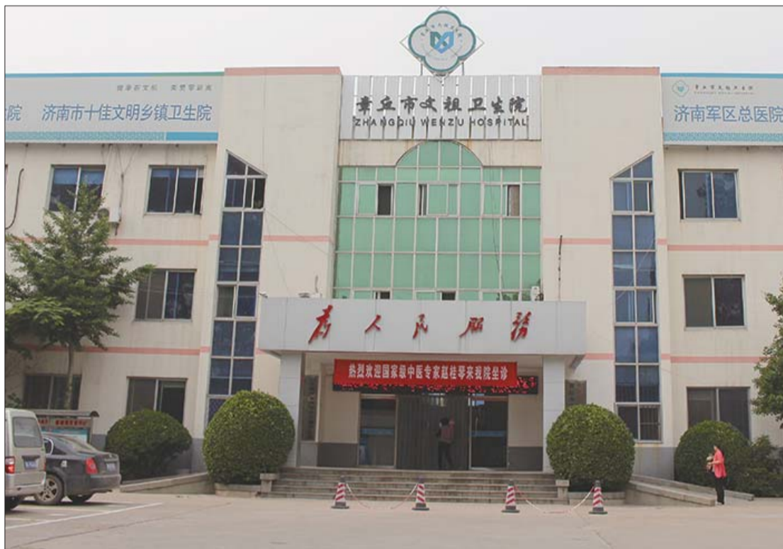
文祖镇卫生院门诊楼
