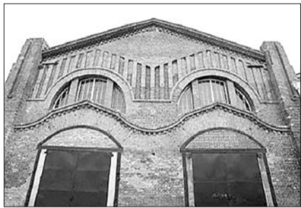
建厂时的德式厂房。
