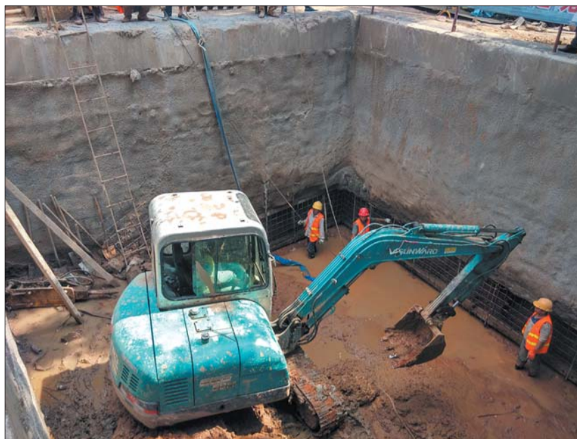
▶位于趵突泉公园内西侧的泵站正在建设中。
