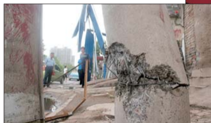
▲现场一片狼藉。 ◀电线杆被泡沫板屋顶刮得从底部断裂。 本报记者 袁文卿 摄
