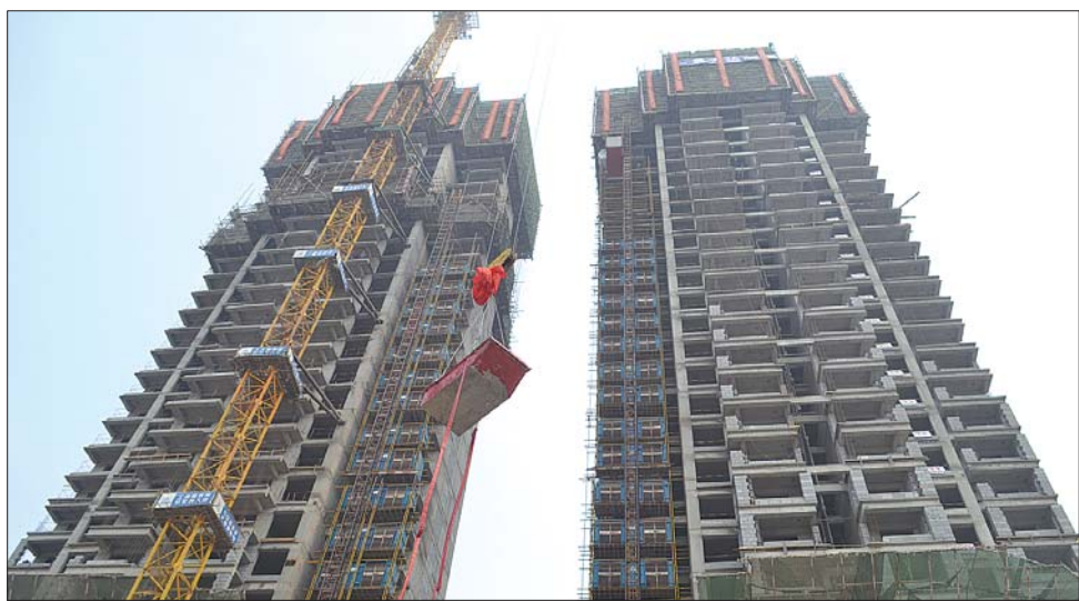
财源街西段旧城区改建工程3栋回迁楼10日成功封顶。本报记者 侯峰 摄
