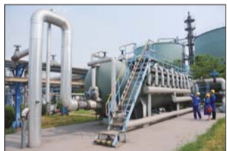
气浮刮渣作业。
