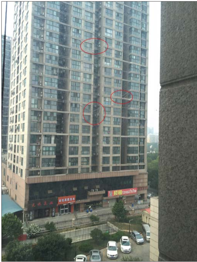
灯带横七竖八挂在外墙上。本报记者 孔令茹 摄
