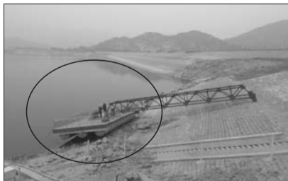
三个月之后,自来水虹吸工程的浮标已脱离水面。本报记者 王世腾 摄
