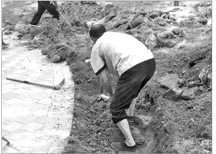
▲工作人员挖出不少建筑垃圾。
