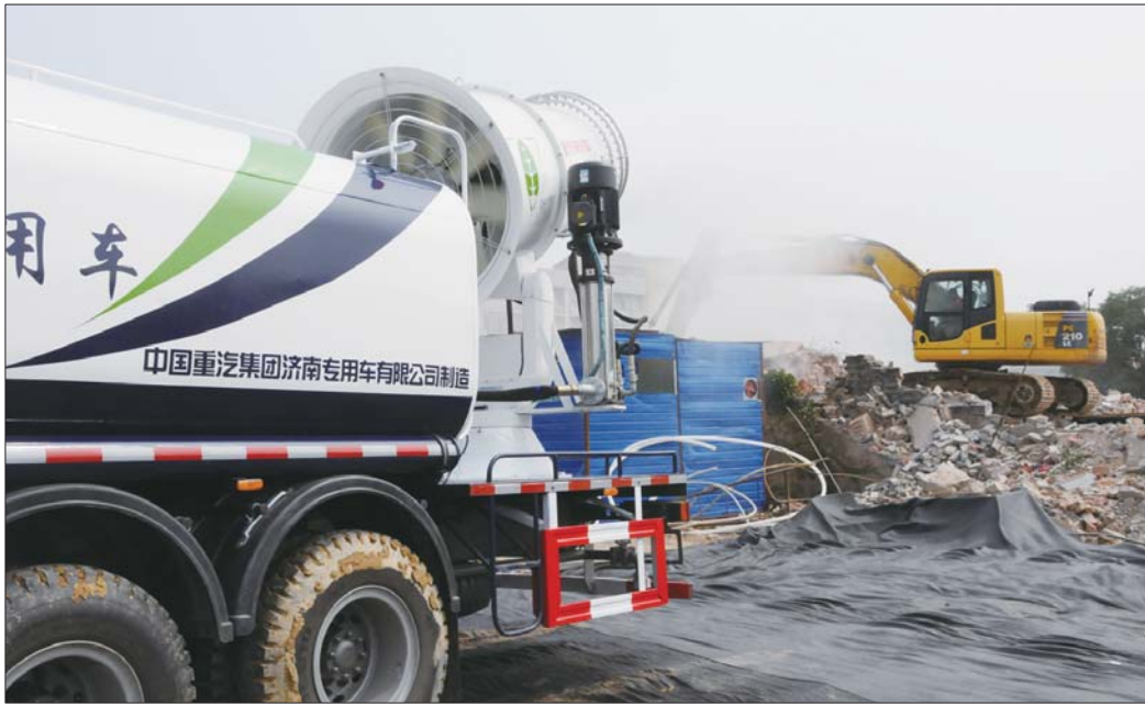
雾炮车正在给工地降尘。
