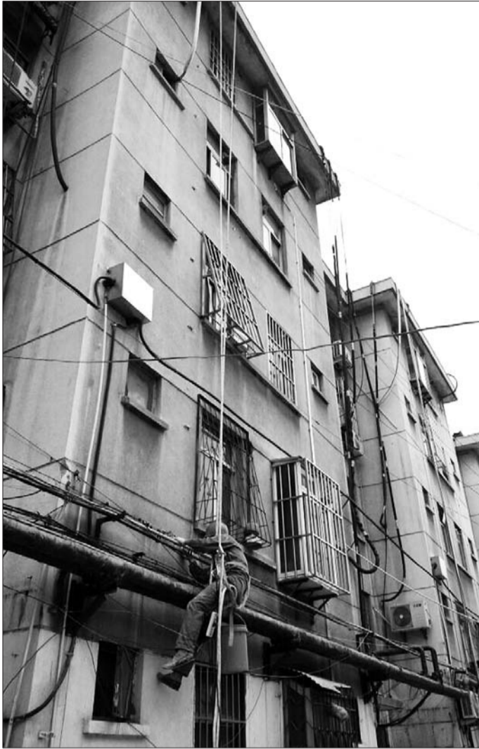
工作人员改造老旧燃气管网。本报记者 康宇 摄
