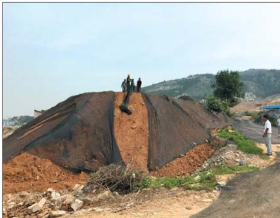
海尔T地块项目施工人员,正在给之前没有完全覆盖的渣土,加盖防尘网。
