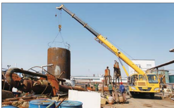
淄博橡塑填料厂拆除现场。(资料片)
