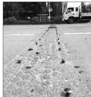
减速带塑胶垫拆除后,只剩铁钉。本报记者 赵兴超 摄
