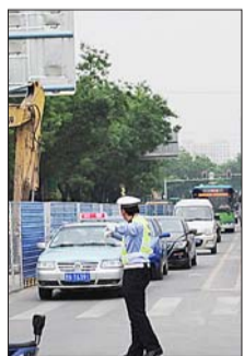
去年5月8日,趵北路正在进行电力沟施工。(资料片)
